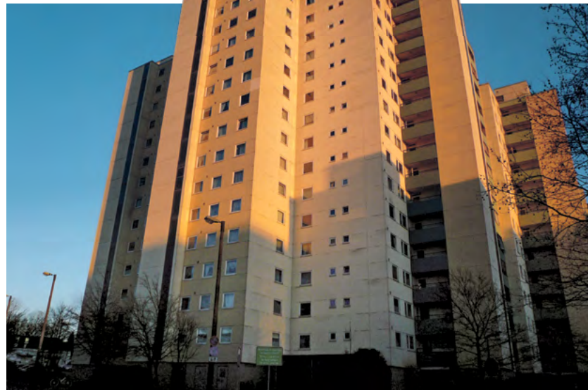
Bei der Grohner Düne handelt es sich um einen ringförmig angelegten und 55 Meter hohen Gebäudekomplex, der sich seit seiner Errichtung zunehmend zum sozialen Brennpunkt entwickelt hat.
