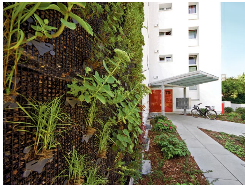
Fassadenbegrünung in der Eislebener Straße in der Gartenstadt Vahr
